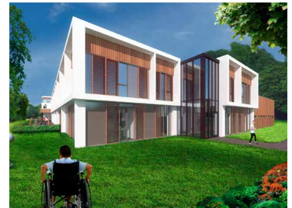
Door de faciliteiten in Huizen en Hilversum te bundelen, kunnen gebouw- en terreinoppervlak flink gereduceerd worden, zonder in te boeten aan (zorg)kwaliteit en comfort.
